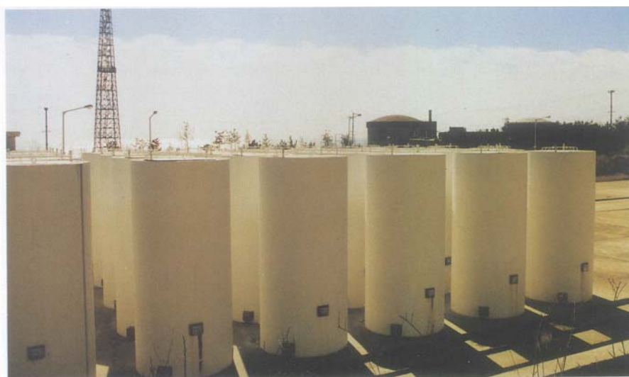
Figura 3 – Cilindri di stoccaggio a secco dell'impianto nucleare di Wolsong in Corea.
